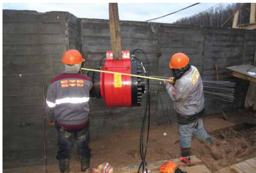
Рис. 4 Натяжение армопучка из 55 арматурных канатов на стенде
